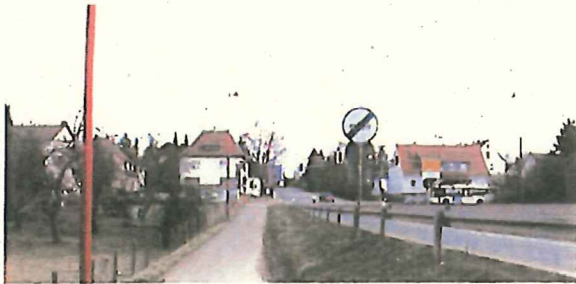
Bild 15 Kreuzung Haupt-/Bahnhofstraße von Westen
