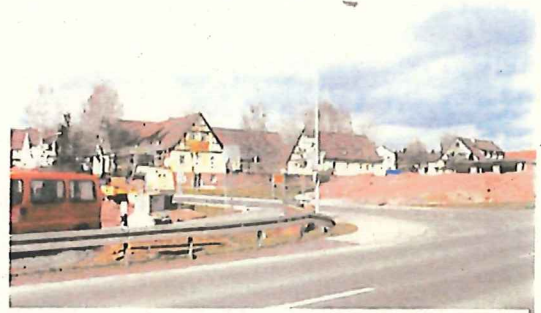
Bild 4 Der in Bau befindliche Abschnitt endet vor dem ehemaligen Wohnheim
