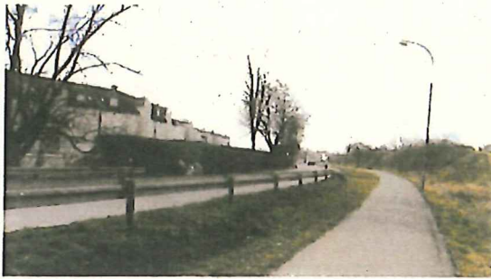
Bild 10 Stark verdichtetes Wohngebiet hinter dem Lärm- schutz-Steilwall
