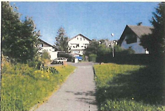
Bild 8 Zugang zur Geschwister-Scholl-Straße, rechts beginnt der Lärmschutzwall
