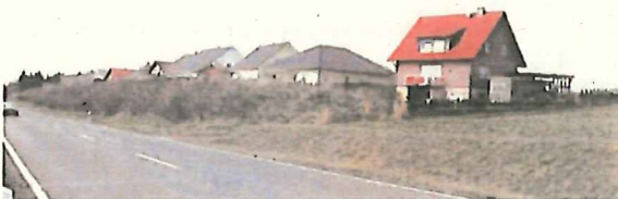
Bild 23 Die Bundesstraße ortseinwärts, rechts die Wohnhäuser oberhalb der Böschung
