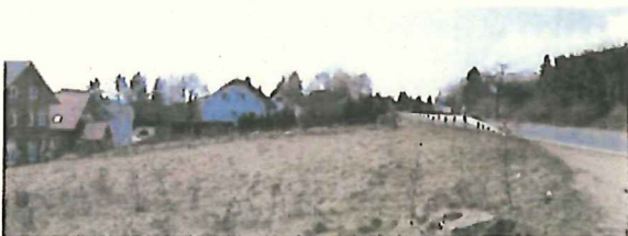
Bild 24 Der Luchgraben liegt wesentlich tiefer als die Bundesstraße
