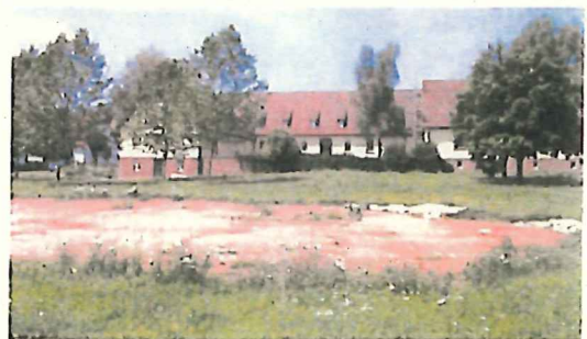
Bild 5 Das ehemalige Wohnheim liegt zurückgesetzt hinter einer Wiese
